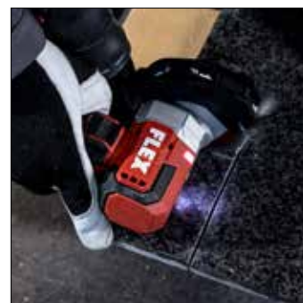
... vrubování dlaždic a přímé odsávání vzniklého prachu...
